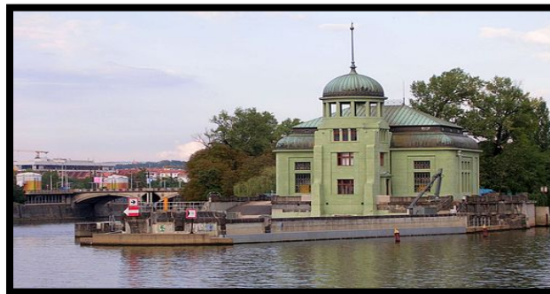
Vodní elektrárna Štvanice, Praha
