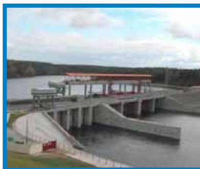
CH Grodnenskaya / Bielorrusia 5 x Kaplan PIT / 18, 870 kW
