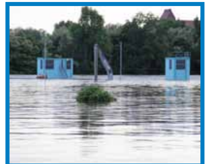
CH Lovosice Casa de Máquinas durante las inundaciones del Río Elba
